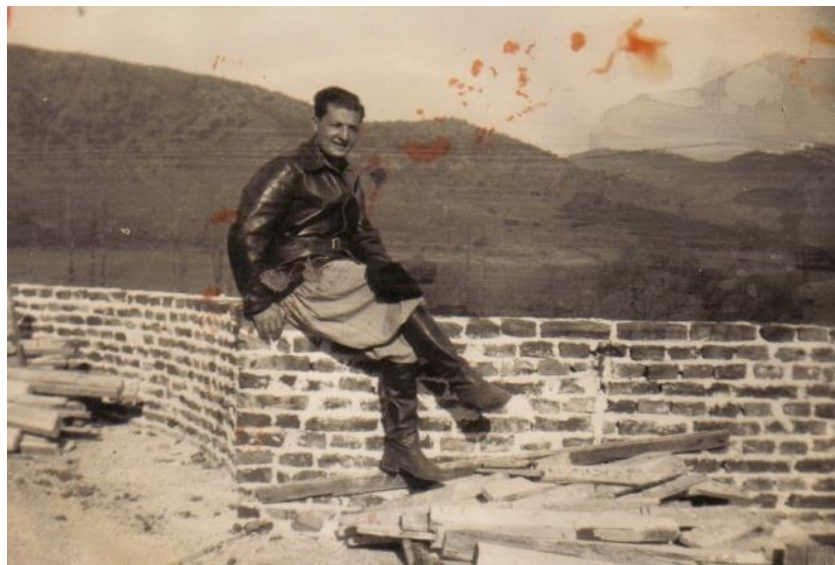
Ezio Armando Carena en el Hotel(Hoy Municipio) Carena en plena etapa de construcción
